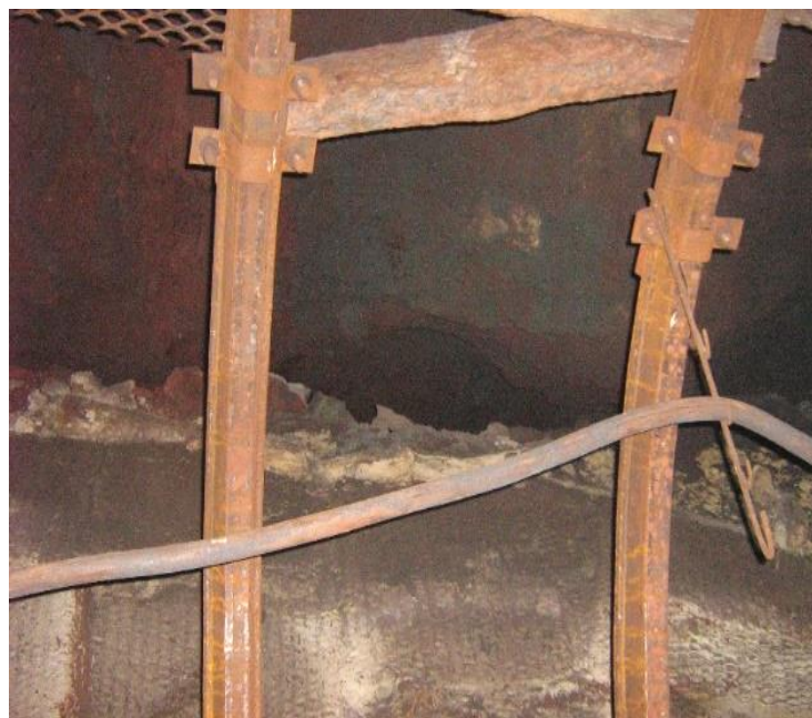
Рисунок 2.29 - Пустоты над бетоном в кровле заходки №22, вид с заходки №23
