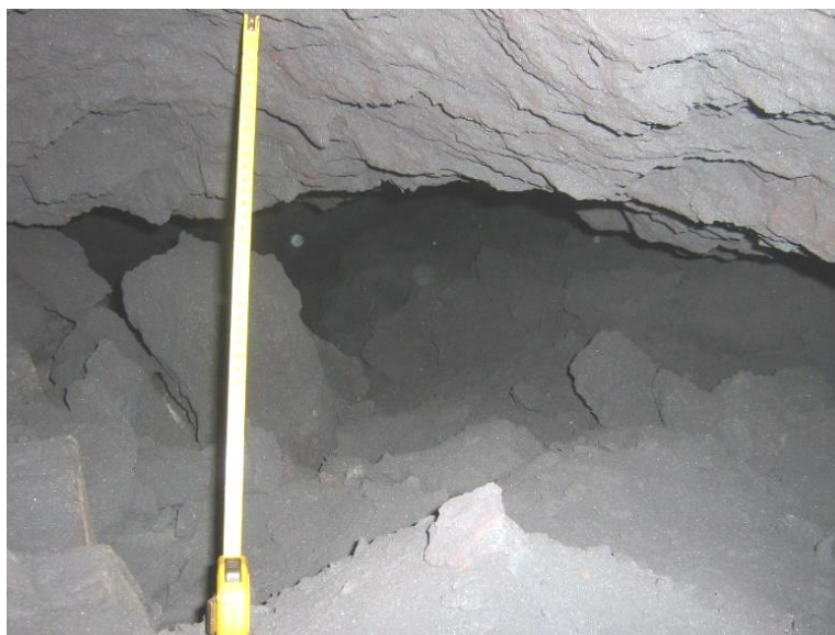
Рисунок 2.30 – Пустоты над бетонной закладкой в очистной заходке №22
