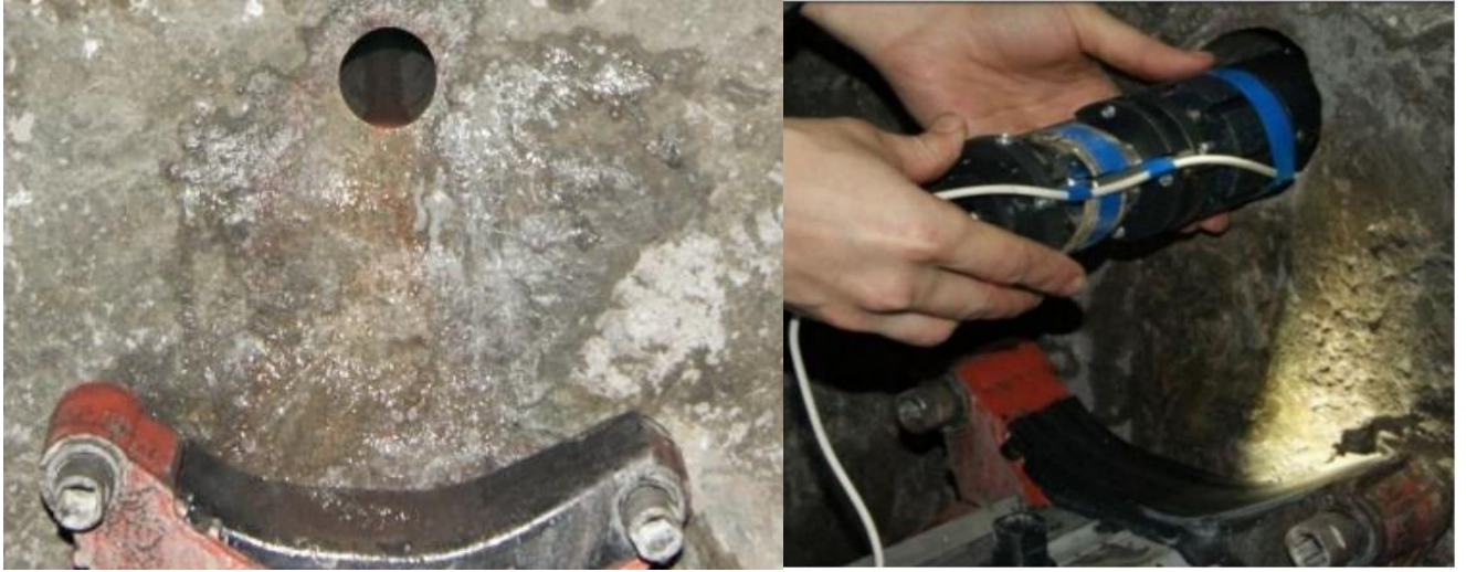
Рисунок 2.14 – Начальные этапы установки трехкомпонентного датчика
