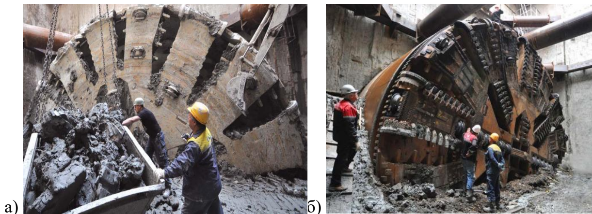
Рисунок 1.18 – Ремонт исполнительного органа: а – откопка исполнительного органа; б – восстановление исполнительного органа
