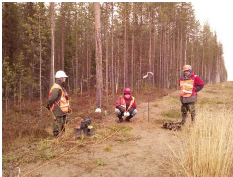
Рисунок 4.1 – Выполнение электроразведочных работ с использованием многоканальной электроразведочной станции «Скала-48»
