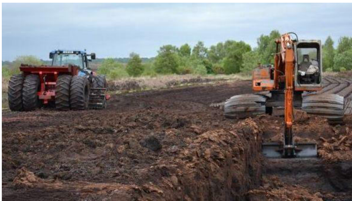
Рисунок 9 – Гидравлический экскаватор и стилочная машина
