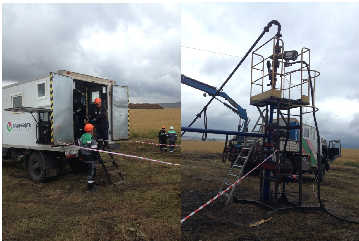
Рисунок 4.2 – Подготовительные работы на скважине №1157 перед проведением гидроимпульсного воздействия на ПЗП
