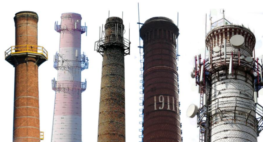
Рисунок 6 – Примеры различных конструктивных деталей дымовых труб
