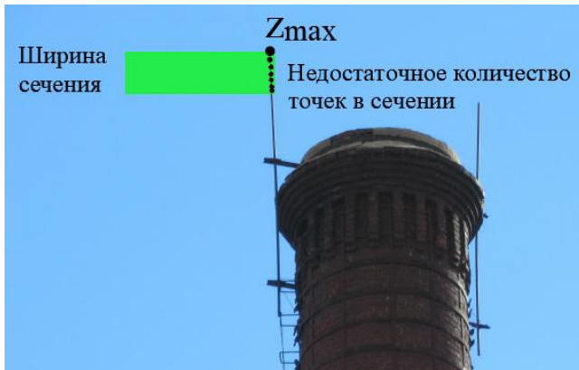
Рисунок 27 – Пример недостаточного количества точек в сечении
