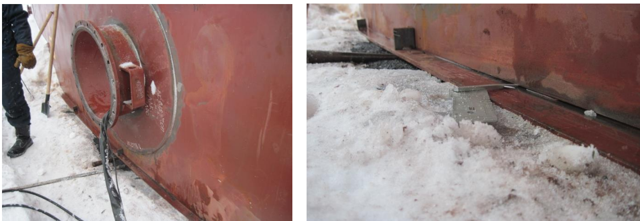
Рисунок 5 – Фото выполнения подтягивания краечного листа на строящемся резервуаре
