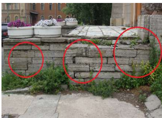
Рисунок 3.35 – Фото деформированных ступеней крыльца со стороны входа в храм (июль 2015 г., автор фото Сальников П.М.)
