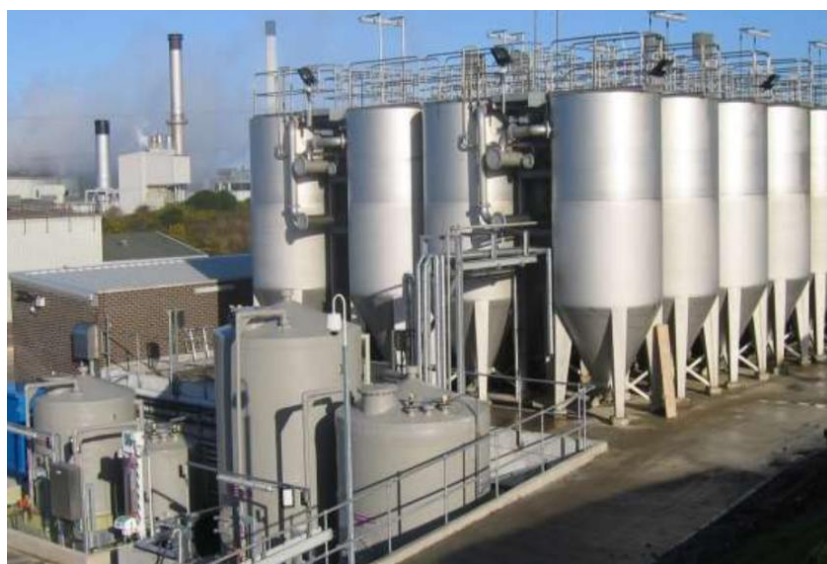
Рисунок 4.4 – Компоновка 20 свободно стоящих фильтров DynaSand
