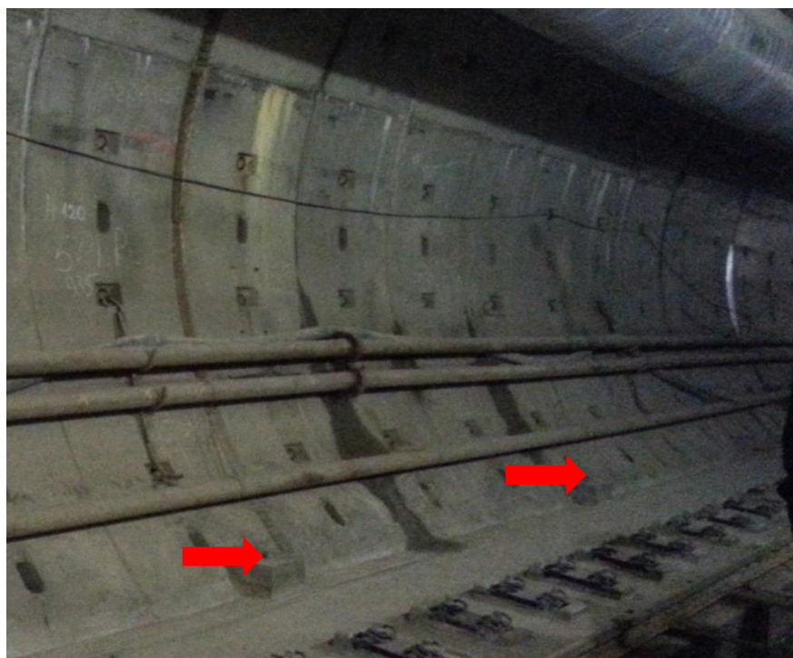
Рисунок 4.1 – Заложённая профильная линия в одном из тоннелей метро г. Санкт-Петербург
