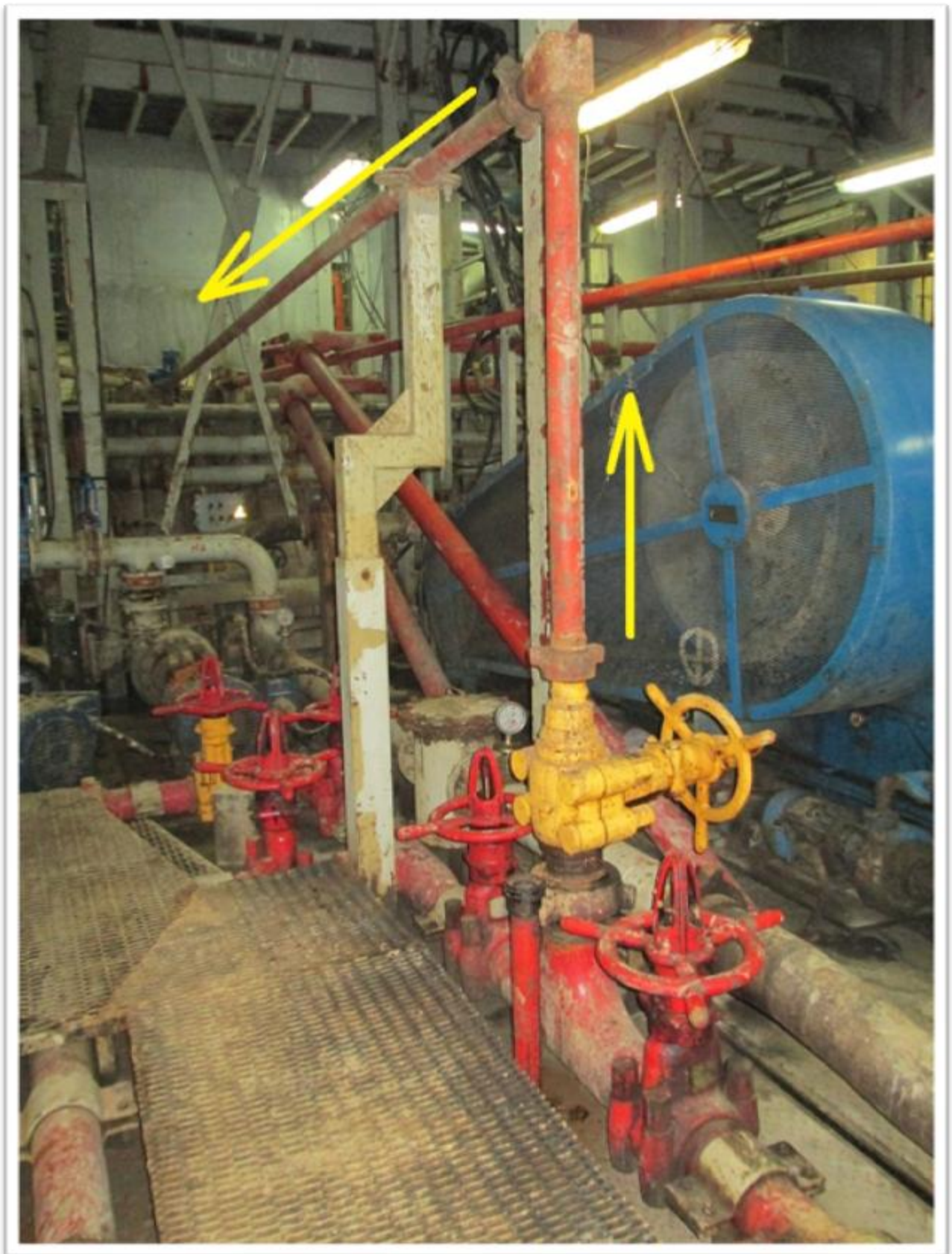
Рисунок 2.5 – Линия подачи жидкости на диспергатор
