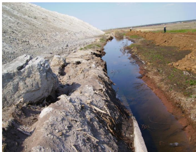
Рисунок 7 – Оползневое смещение с выдавливанием глинистых грунтов из-под отвала
