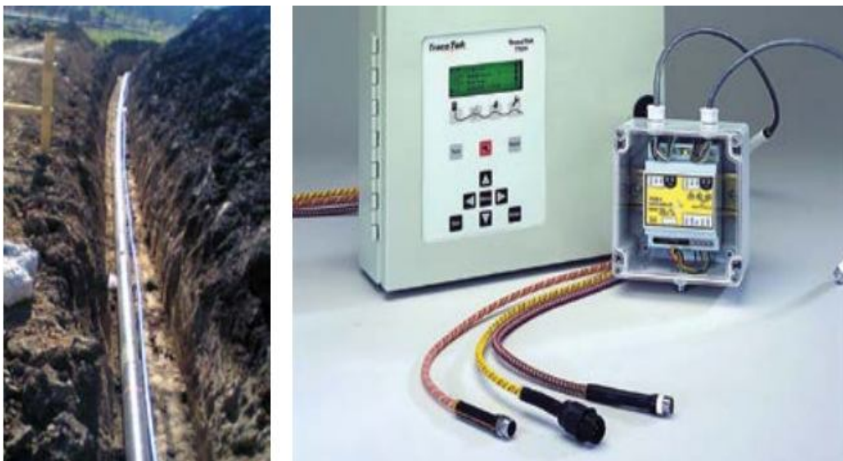
Рисунок 2.7 – Участок нефтепровода с проложенным газочувствительным кабелем
